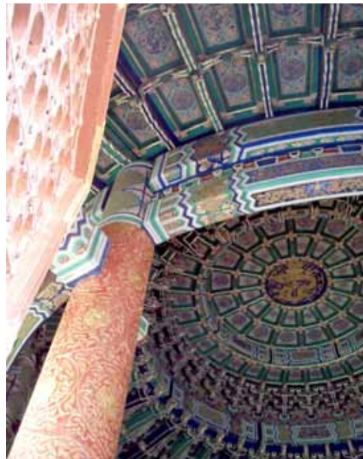
Pawilon Modłów o Dobre Zbiory został wybudowany bez użycia gwoździ, kopuła wspiera się na 28 drewnianych kolumnach
