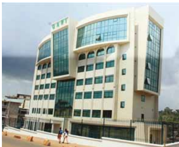
Siedziba OAPI w Yaoundé (w budowie)
