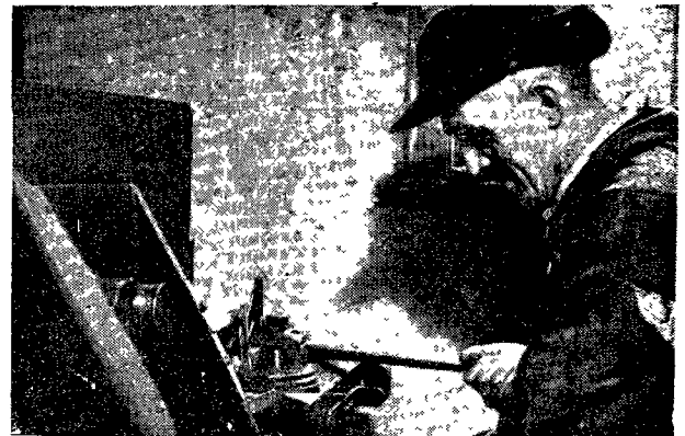
Mistrz ślusarski Kloss skonstruował specjalną obrabiarke, dzięki której można wyprodukować dziennie 12.000 sztuk śrub, podczas gdy do tej chwili wykonywano zaledwie 180 sztuk dziennie.
