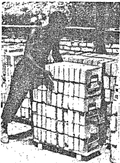
Rys. 3. Cegły w zasobnikach przygotowane do transportu.
